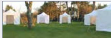
Ces stands sont destinés exclusivement aux implantations de courte durée, après consultation préalable de la météo locale. Ils doivent être démontés ou évacués à partir de 50 km/h de vent. Si la liaison au sol est faite à l'aide de poids de lestage, prévoir 15 à 20 kg par pied.
